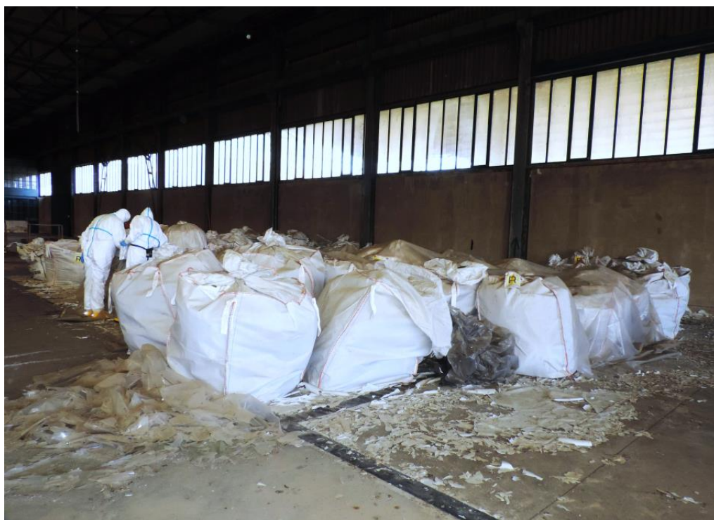
Figura 3. Preparazione di rifiuti contenenti amianto in big-bags
