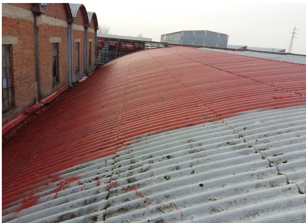
Figura 2. Coperture in cemento-amianto parzialmente incapsulate
