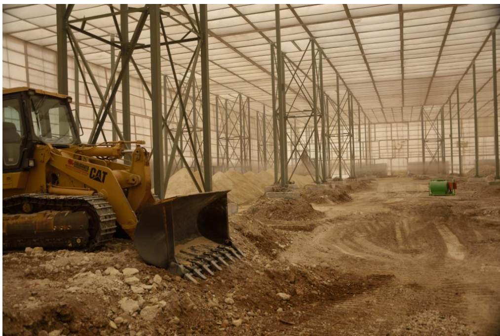
Figura 12. Bonifica di suoli contaminati da amianto eseguita in confinamento statico-dinamico di grandi dimensioni
